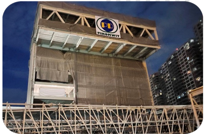
การก่อสร้าง
